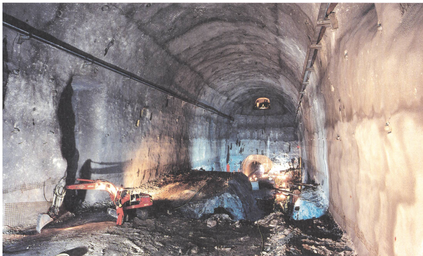
Travaux d'excavation pour la nouvelle centrale en caverne de Bieudron (aménagement Cleuson-Dixence, VS).
