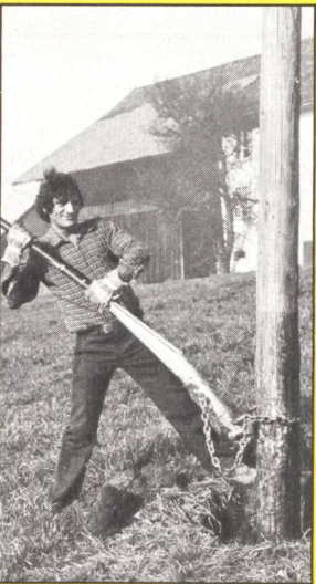
Nachimprägnierung von Holzmasten
