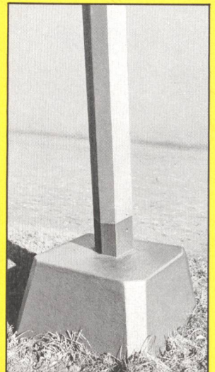
Betonschutz an Mastsockeln
