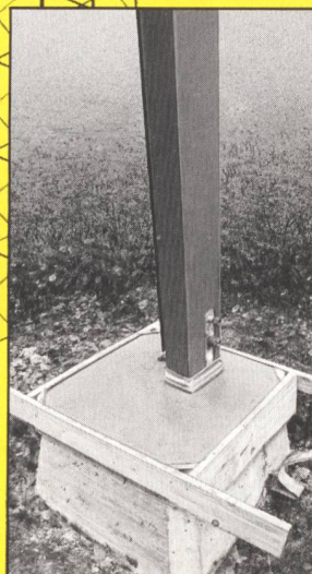
Sanierung von Mastsockeln
