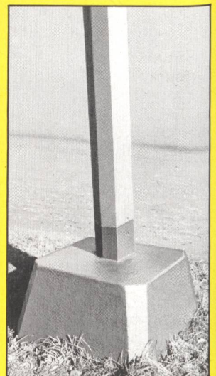
Betonschutz an Mastsockeln
