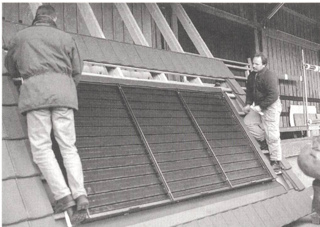
Solkit, das solare Kleinsystem zur Produktion von Warmwasser, lässt sich in einem Tag ohne Staub und Baulärm montieren.
