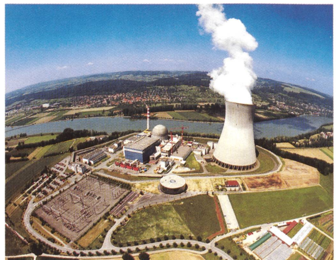
Rekordproduktion für Schweizer Kernkraftwerke (Bild: KKW Leibstadt).
