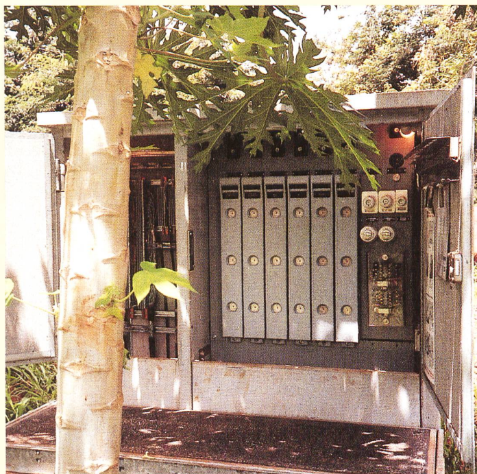
Kabelverteilkabine Gr. II, TV-Typ C
