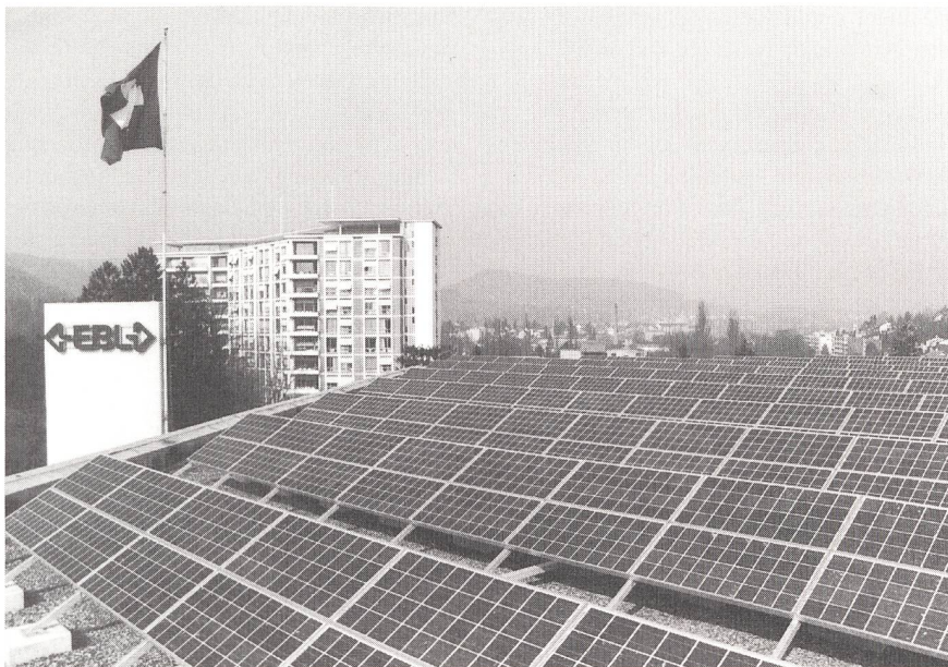
Photovoltaik-Anlage auf dem Dach des EBL-Magazingebäudes.
