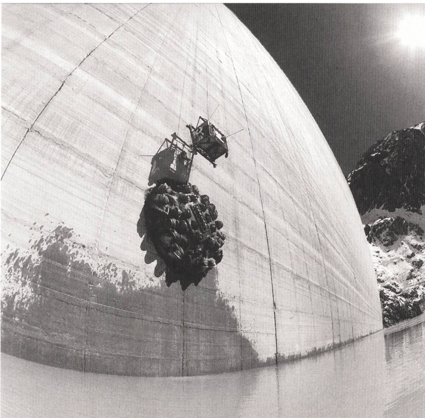
Le barrage de la Grande Dixence a été percé par un tunnelier d'un diamètre de 4,40 mètres.
