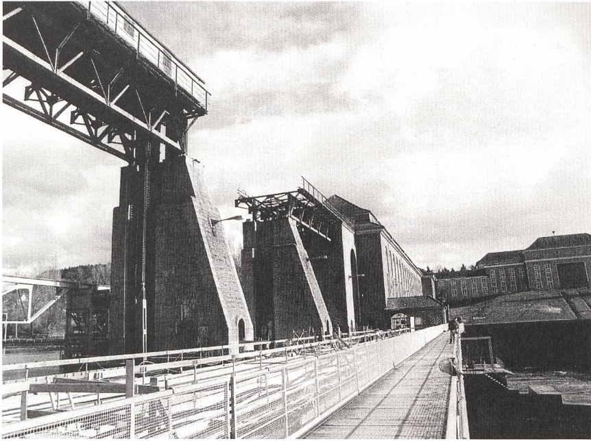
Das markante Wasserkraftwerk Eglisau bei Rheinsfelden feiert seinen 75. Geburtstag.
