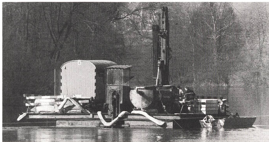
Sondierbohrung auf der Aare für den Neubau des Wasserkraftwerkes Ruppoldingen der Atel.
