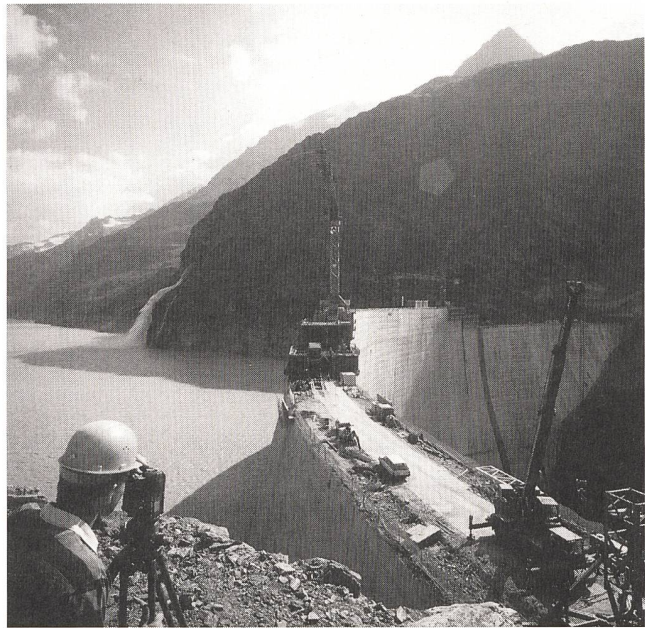
Erhöhung der Staumauer von Mauvoisin (VS) auf 250 m Höhe (1989-1991).
