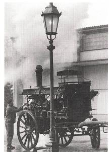
Bild 1b Dampfstrom-Elektrogruppe, Jahrgang 1889, für Pferdezug, Leistung etwa 8 kW (10 PS) (Foto Scagnet).
