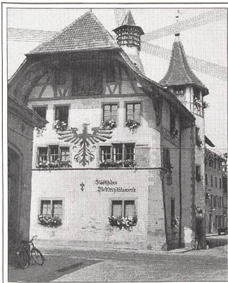
Obere Mühle, Aarau, erbaut 1608 Städtisches Elektrizitätswerk 1893-1907
