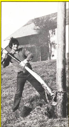
Nachimprägnierung von Holzmasten
