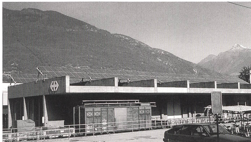
Bild 1 Photovoltaikanlage auf dem Dach des Fahrleitungsgebäudes.
