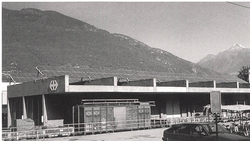
Bild 1 Photovoltaikanlage auf dem Dach des Fahrleitungsgebäudes.
