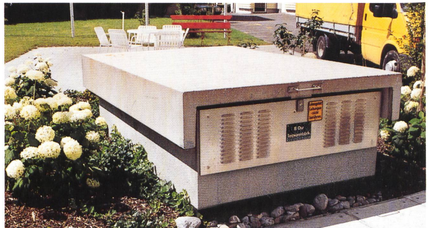
Fertig-Transformatorstation, Typ: Unterflur C
