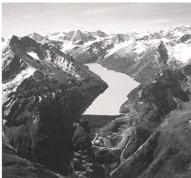
Figure 1 Le barrage de la Grande Dixence dans le canton du Valais, Suisse, permet d'accumuler 400 millions de m 3 d'eau. Il s'agit d'un barrage-poids avec un volume de béton de 6 millions de m 3 . De nombreuses galeries de contrôle permettent de surveiller cet ouvrage.
