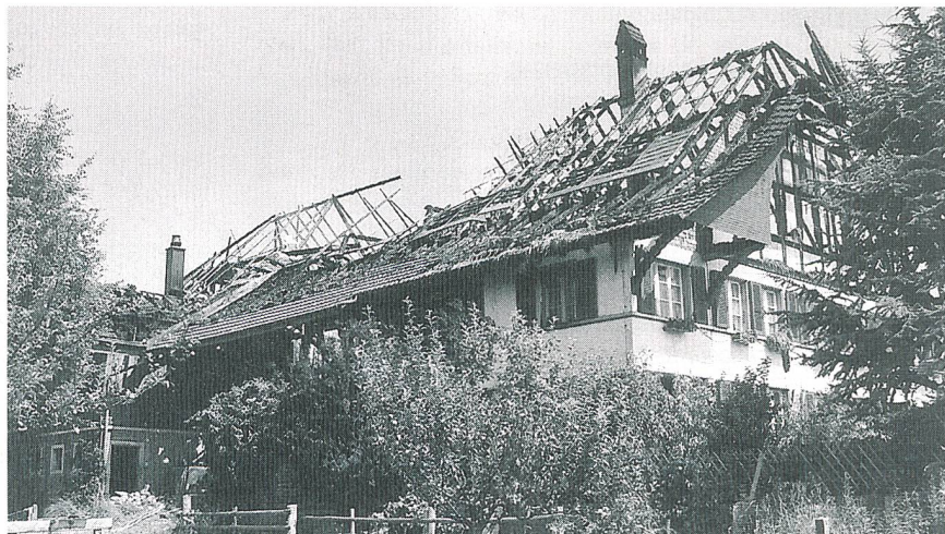
Destruction considérable de la ferme
