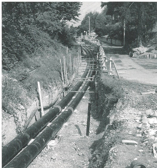
Mit Wärmetransportleitungen wird die Abwärme zu den Wärmebezüglern der Refuna transportiert
