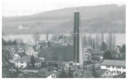
Bild 2 Kirche Steckborn. Die südliche Turmseite trägt eine 19,4-kW-Photovoltaik-Anlage
