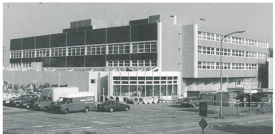
Bild 3 Fassadenintegrierte Photovoltaik-Anlage am Neubau der Betriebsleitzentrale der Genossenschaft Migros Winterthur/Schaffhausen. Die Solarmodule sind vollständig in die Fassade integriert und ersetzen das an den andern Fassadenbereichen verwendete Sinusblech
