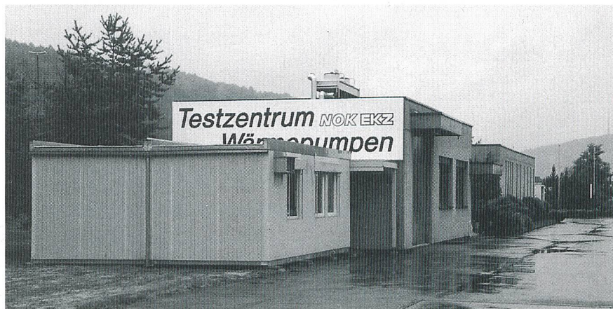
Bild 1 Testzentrum für Wärmepumpen: Das von der Fördergemeinschaft Wärmepumpen im Unterwerk Töss der NOK eingerichtete Wärmepumpentest- und Ausbildungszentrum wird seit 1993 von den NOK und EKZ als separate Gesellschaft betrieben (Photos K. Heimberg)
