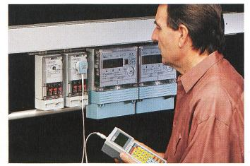
Die FTU-Programmierung erfolgt über eine optische Schnittstelle mittels PC, Handterminal T3000 u.a.
