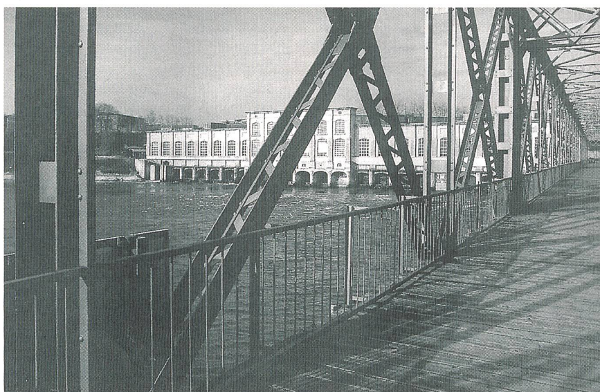
Das Rheinfelder Flusskraftwerk – die «Wiege» der europäischen Elektrizitätsgewinnung
