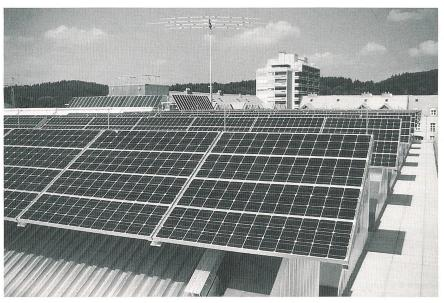
Bild 3 Teilansicht des Solargenerators der ISB-Anlage mit Miniaturblitzfängern
