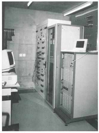
Bild 8 Blick in den Photovoltaik-Schaltraum der ISB mit Sammelschienenschrank, Messschrank und dreiphasigem 20-kW-Wechselrichter
