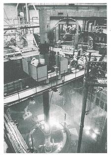
Bild 4 Der Sicherheit wird im Kernkraftwerk Beznau seit jeher höchste Priorität eingeräumt. Bild: Prüfeinrichtung für die Inspektion des Reaktor-Druckgefässes
