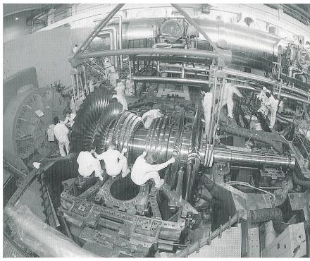
Bild 1 Der neue Rotor (Gewicht 67 t) der dritten Niederdruck-Dampfturbine im KKW Leibstadt wird eingebaut. Links die Abschirmwand und ein Teil des Generators (Bild KKL)
