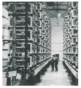
Zwölf haushohe Türme vollgepackt mit elektronischen Bauteilen verwandeln in der Gleichstrom-Kupplung Etzenricht den Drehstrom aus dem Versorgungsnetz einmal in Gleichstrom und wieder zurück. Nur mit diesem technischen Kniff können die beiden unterschiedlichen Stromnetze in West- und Osteuropa miteinander verbunden werden
