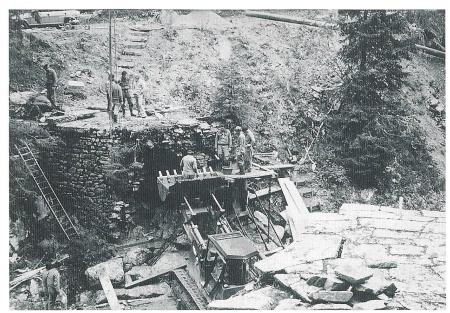
Bild 9 Restaurierungsarbeiten am rechten Widerlager (1982) Figure 9 Travaux de restauration sur la culée droite (1982)
