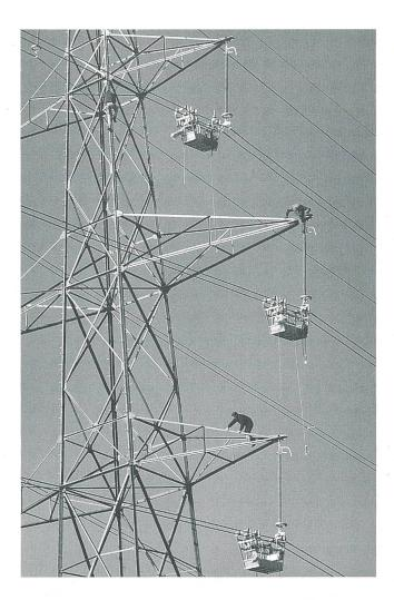
Figure 6 Ligne 380 kV Romanel-St-Triphon (VD); changement de câbles (Studio Curchod)
