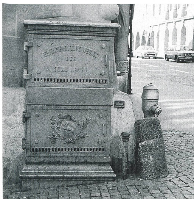
Bild 5 Im Innern der Städte wurden die Stromleitungen von Anfang an unsichtbar im Boden verlegt. Die dafür verwendeten oberirdischen Abzweig- und Sicherungskasten sind meist besonders sorgfältig entworfen worden. In Stahl gegossen erhielten sie neben der Bezeichnung Elektrizitätswerk auch Stadtwappen und Namen. Als wichtige Zeugen der Elektrifizierung sind sie in Ortsgeschichten zu dokumentieren und in Ortsmuseen, wie andere wichtigen Artefakte auch, zu sammeln (Bern)
