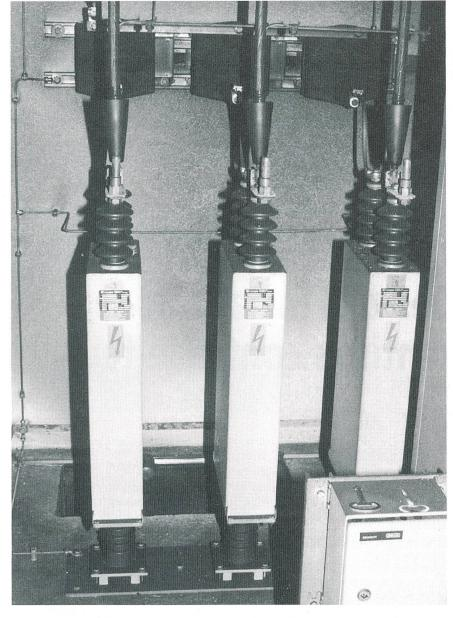
Figure 2 Exemple de filtre de couplage d'une télécommande centralisée endommagé par des fumées
