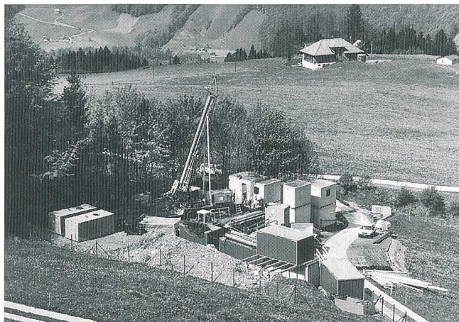
Eine der Sondierbohrungen am Wellenberg
