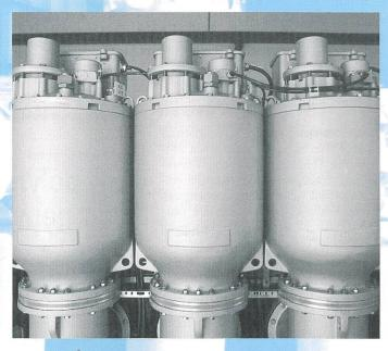
GASCOIL® SF<sub>6</sub> - isolierte Messwandler für autonome und integrierte GIS Anwendungen GASLINK® SF<sub>6</sub> - isolierte Stromschienen (Hintergrundbild)
