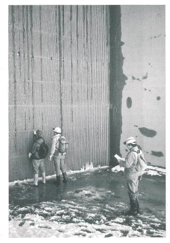
Der zehn Meter hohe Feinrechen im Einlaufbauwerk der Staumauer Limmernboden präsentierte sich der Inspektionsequipe dank des treibholzfreien Wassers (der Limmernsee liegt über der Baumgrenze) auch nach dreissig Betriebsjahren unbeschädigt und in gutem Zustand
