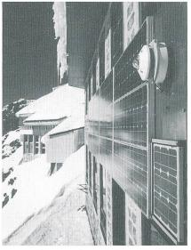
Titelbild: Auf dem Jungfraujoch (3454 m) betreibt die Ingenieurschule Burgdorf die höchstgelegene netzgekoppelte Photovoltaikanlage der Welt. Das Titelbild zeigt den Solargenerator der Anlage an der Fassade der hochalpinen Forschungsstation Jungfraujoch (Blick in Richtung Nordwest, Restaurant Jungfraujoch im Hintergrund). (Photo ISB)
