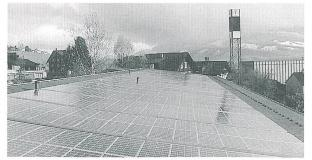
30 kWp PV-Anlage in Meggen (Schrägdachmontage)
