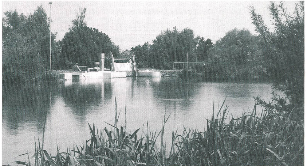
An der Tagung wird unter anderem das Kleinwasserkraftwerk Murg des Elektrizitäts- und Wasserwerks Sirnach besichtigt werden können. Es verfügt über eine Leistung von 125 kW und nutzt das Wasser eines Weihers. Es dient der Produktion von Spitzenenergie und gilt gleichzeitig als Notstromquelle für ein Pumpwerk der Wasserversorgung in der Region
