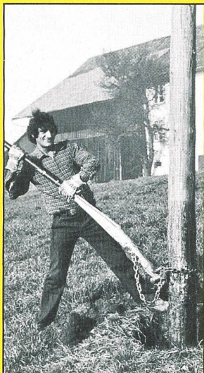
Nachimprägnierung von Holzmasten
