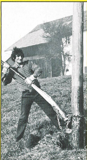
Nachimprägnierung von Holzmasten
