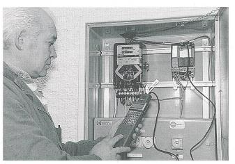
Bild 7 Rundsteuerempfänger LCR500 mit Handparametriergerät LCP500
