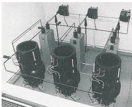
Bild 4 Mittelspannungs-Parallelankopplung (seit 1968)
