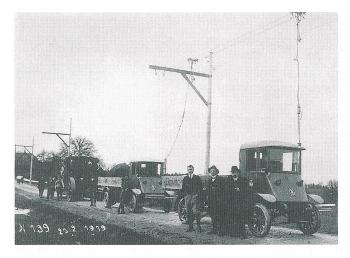
Bild 2 Tempi passati! Im BKW-Museum finden sich solche Bilder aus der Bauzeit des Wasserkraftwerks. Die nach dem Trolleybus-System elektrisch betriebenen Lastwagen besorgten den Transport zwischen der Bahnstation Gümmenen und der Baustelle
