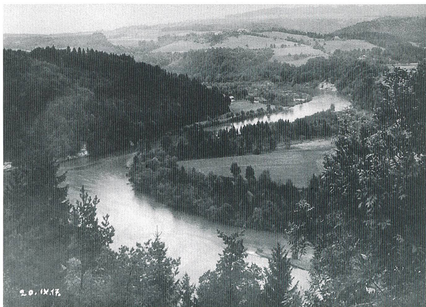
Bild 1 Diese Aufnahme vom September 1917 zeigt das Engnis, an dem kurz darauf mit dem Bau des Wasserkraftwerks Mühleberg begonnen wurde
