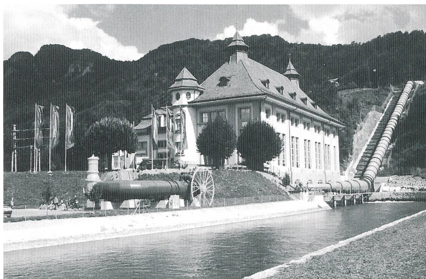
Bild 1 ELECTROBROC, ein bemerkenswerter Standort
