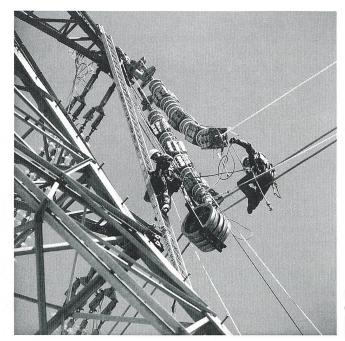
Figure 7 Installation d'isolateurs polymeriques pour la ligne de 400 kV Deeside–Pentir
