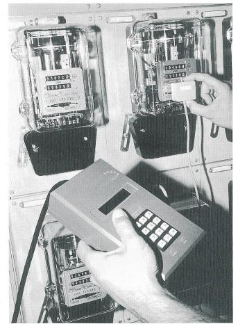
Bild 1 Der Stromzähler wird von einem optischen Sensor abgetastet. Das Basisgerät (Hintergrund) berechnet Leistungs- und Energieverbrauch und sendet die Ergebnisse auf das 230-V-Netz
