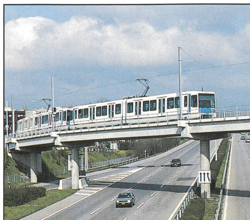
Die TSOL verbindet die Hochschulen (UNIL und ETHL) mit dem Zentrum der Stadt Lausanne
