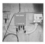
Bild 3 Einer der zwölf in der Mauvoisin-Mauer installierten seismischen Beschleunigungsmesser
