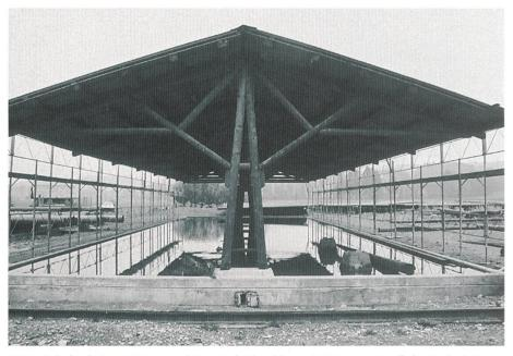
Bild 1 Halle für die Imprägnierung nach dem Impfstichverfahren mit Trägern aus Rundholz. Die durch Zug beanspruchten Streben wurden mit Ultraschall getestet, um ein höheres Beanspruchungsniveau zu erreichen als nach der Norm SIA 164. Bauherr: Société romande pour l'imprégnation des bois, Palézieux. Ingenieur: Bois Consult Natterer, Etoy; Zimmermann: Stöckli et fils, Oron
