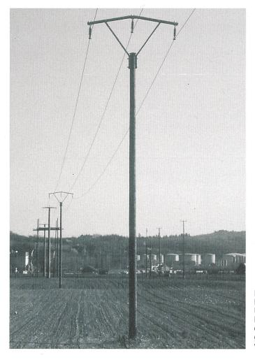
Bild 9 Beispiel einer Holzstütze: ein mit Ultraschall getesteter Mast der Klasse extrastark mit Auskragungen aus Metallträger von Aldrey-Leitern
