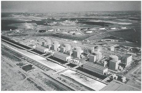
Bild 1 Kernkraftwerk Gravelines bei Dünkirchen: 6 Blöcke mit insgesamt 5460 MW Leistung
