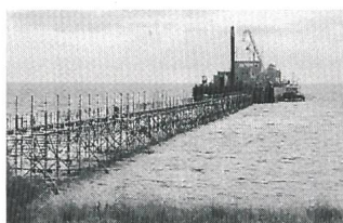
Arbeiten am «Baltic Cable» vor der schwedischen Küste
