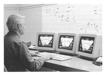
Leitzentrale des neuen Mess- und Datenübertragungssystems Watal der Kraftwerke Vorderrhein ist die regionale Netzsteuerstelle im Kraftwerk Tavanasa. Hier laufen alle wichtigen Betriebsdaten von Staumauern und Wasserfassungen zusammen. Farbmonitore sowie ein Mosaik-Wandschaltbild geben dem Personal Auskunft über die gewünschten Messwerte
