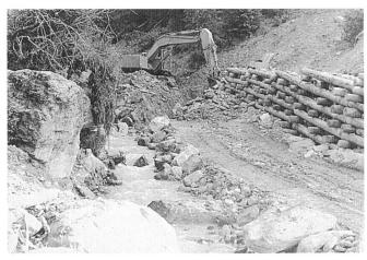
Mit der im Bau befindlichen Uferstabilisierung soll das unkontrollierte Nachrutschen eines instabilen Hangbereichs der Schmuerbachschlucht verhindert
