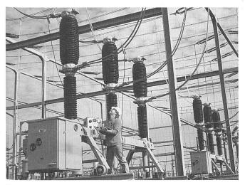
Prüfung an SF<sub>6</sub>-Leistungsschalter vor Inbetriebnahme einer 123-kV-Schaltanlage
