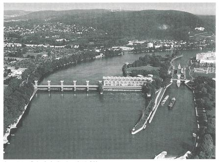
Figure 6 Installation hydroélectrique de Birsfelden Vue d'ensemble de l'installation comprenant les canaux d'amenée et de fuite, l'écluse, les turbines (logés dans le bâtiment près de l'écluse) et les vannes
