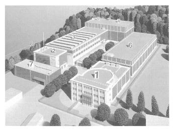
Zentrales Zwischenlager Würenlingen – Modellaufnahme: 1 Konditonierungsanlage und Bürotrakt, 2 Verbrennungs- und Schmelzanlage, 3 Behälterlagergebäude, 4 Lagergebäude für mittelaktive Abfälle, 5 Heisse Zelle, 6 Lagergebäude für schwach- und mittelaktive Abfälle, 7 Bundeszwischenlager, 8 Aar
