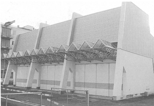
Beim neuen Unterwerk Schweizerhalle war zwar wie bei allen Anlagen dieses Typs die Funktionalität oberstes Gebot, mit der Verwendung postmoderner Architekturelemente konnte aber eine Lösung gefunden werden, die auch architektonisch überzeugt
