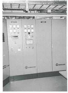
Bild 3 Schaltschrank des BHKW
