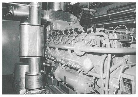
Bild 1 Modul des BHKW mit Gasmotor
